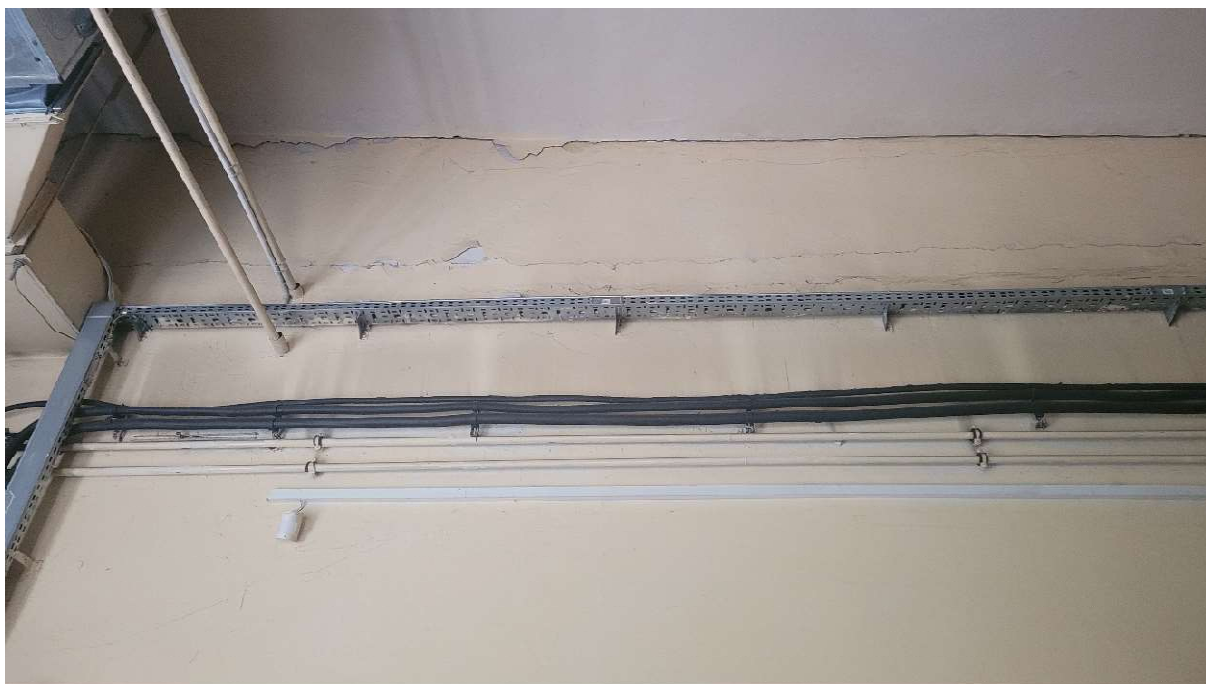
Strop w pomieszczeniu hydroforów
