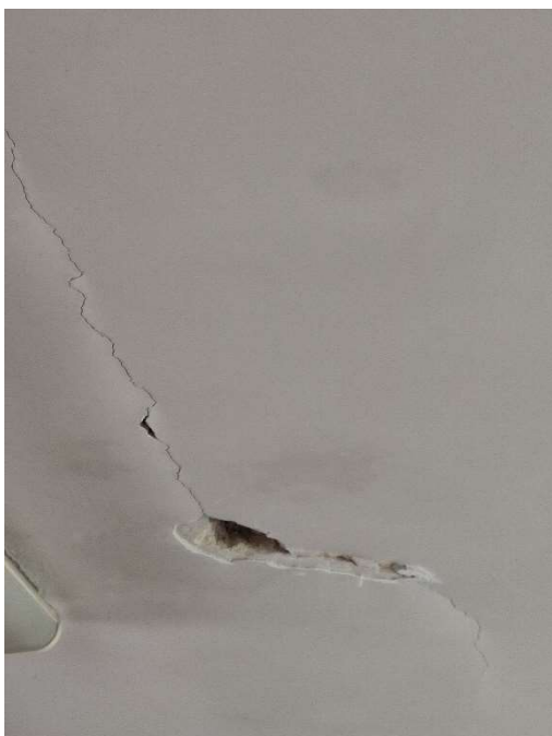
Strop w pomieszczeniu jadalni
